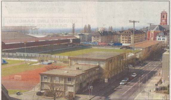
L'essentiel du site avant le début des travaux...
